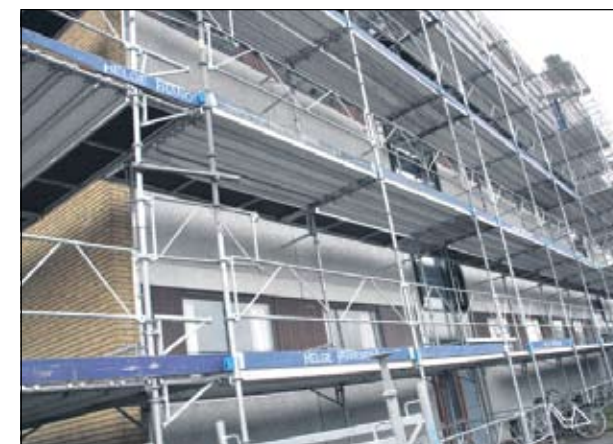
Et større stilladsarbejde går igang hver gang der startes på en ny blok. Helge Frandsen A/S har fået opgaven til stor tilfredshed for projektlederen.
